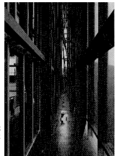
写真3 遮音と断熱を考慮した 二重層ガラスと サウンドロック
